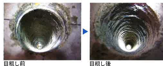
目粗し後の孔壁内面
