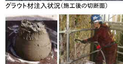
可塑性グラウト材 グラウト材注入(横向き)
