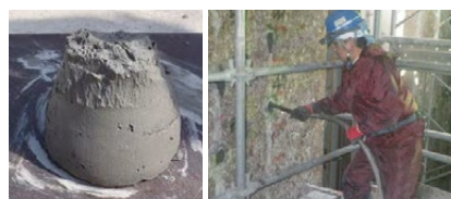
可塑性グラウト材 グラウト材注入(横向き)
